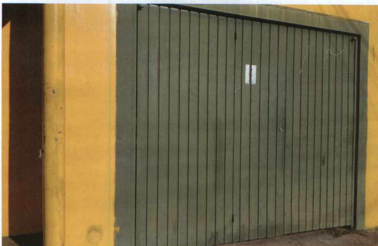
(FOTO 01 – MOSTRA PORTÃO DE ACESSO AO IMÓVEL - CASA)
