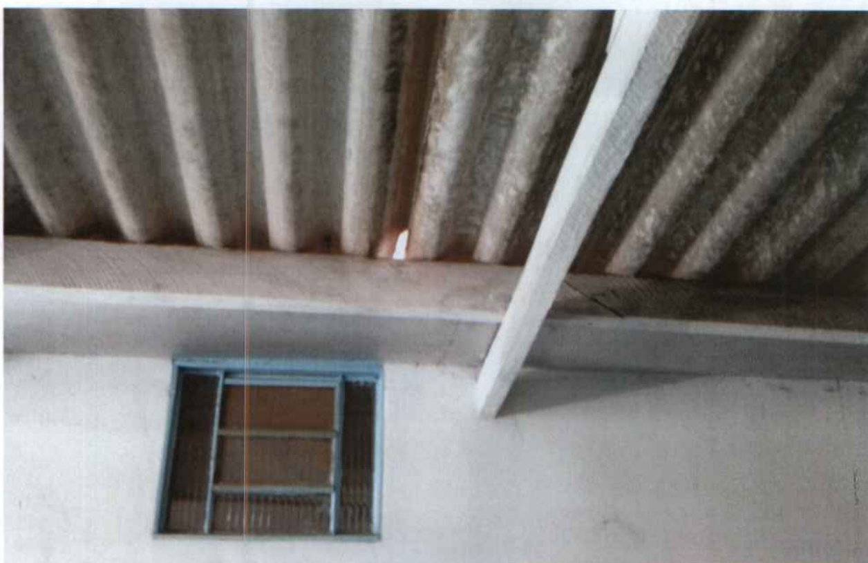
(FOTO 12 – MOSTRA COBERTURA DA VARANDA, EM TELHA DE FIBRO AMIANTO - CASA)
