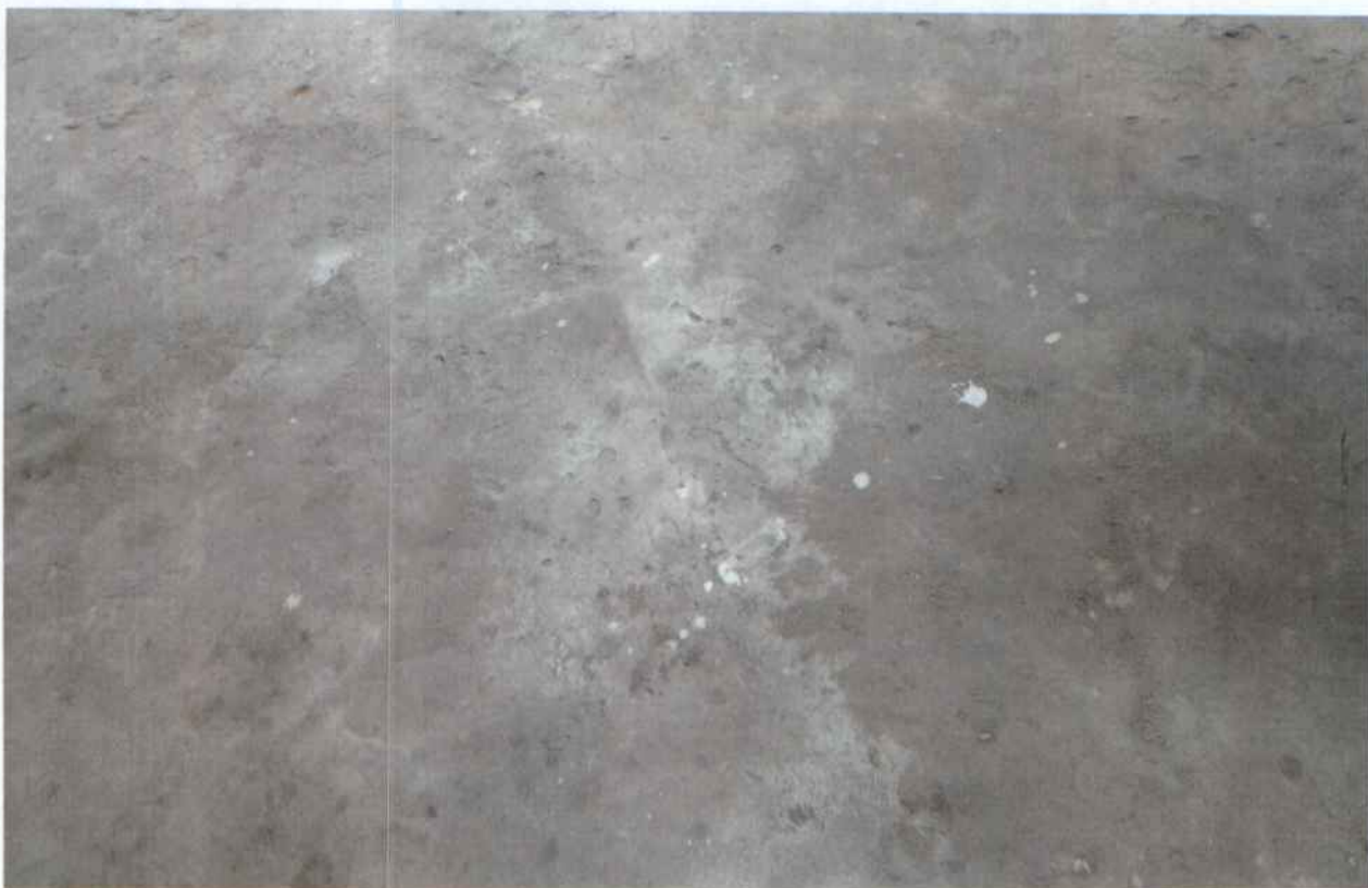
(FOTO 07 – PARTE EXTERNA – PISO CONTRAPISO)
