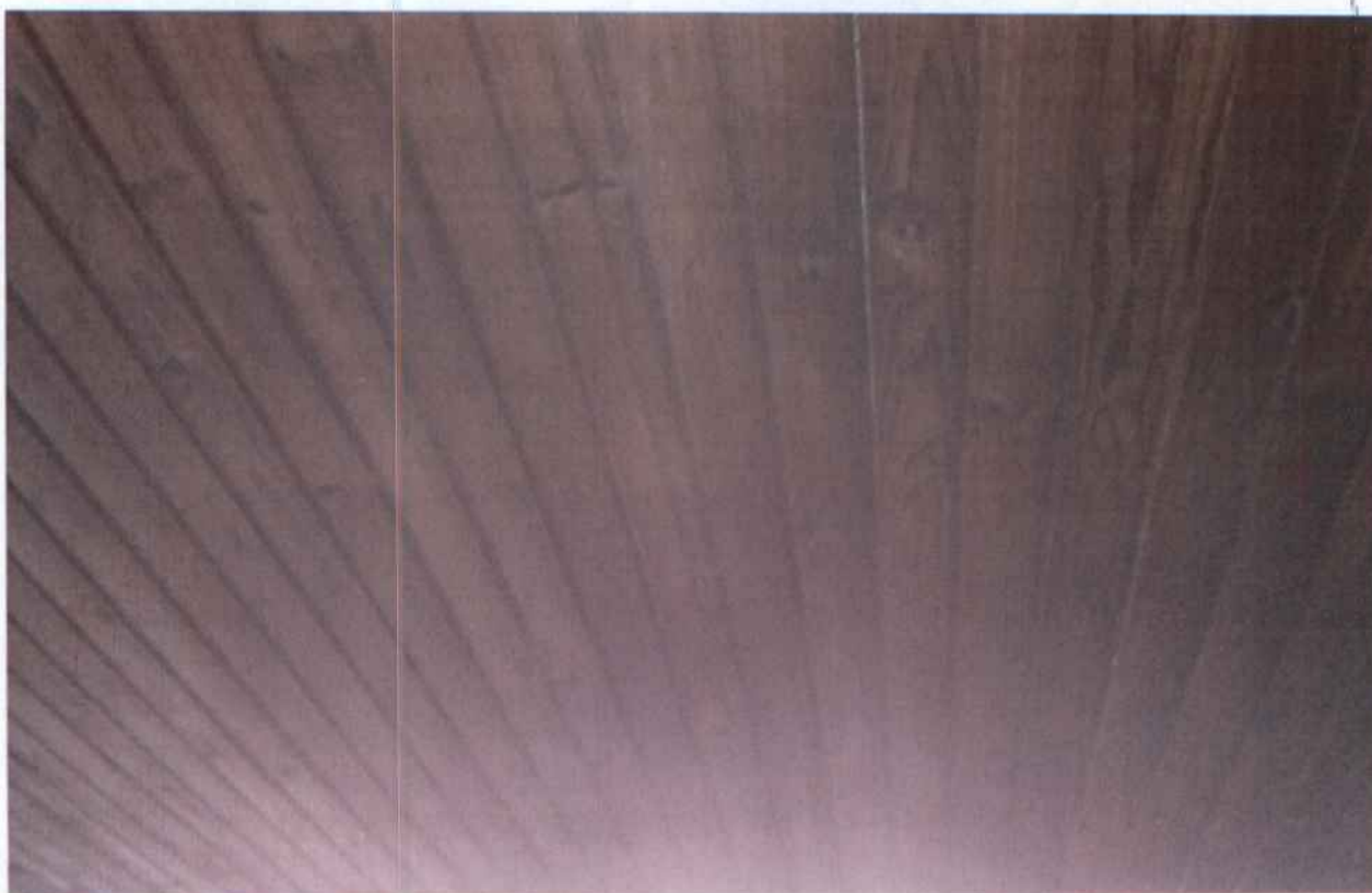
(FOTO 13 – MOSTRA PARTE DO FORRO, EM MADEIRA – SALÃO COMERCIAL)
